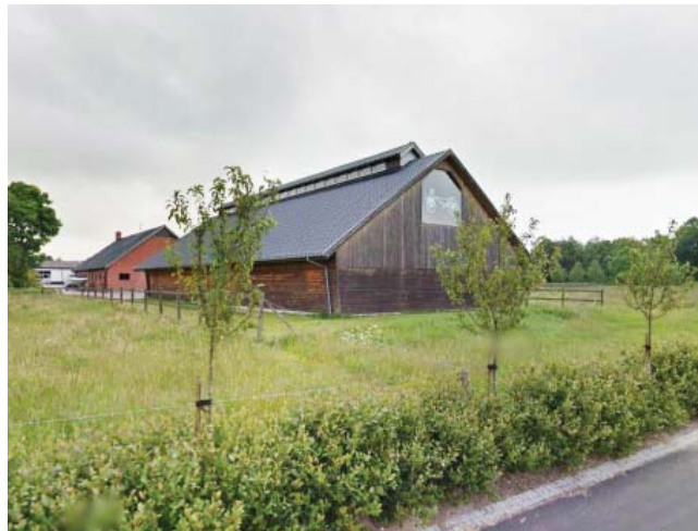
Ladebygningen set fra Koustrup Mark
